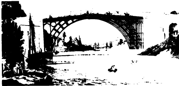
٢٦٢ جسر كولبروكديل في شروبشر. ١٧٧٧ - ١٧٨١. تصميم برنجانارد. يعتبر أول جسر انشاء من مادة الحديد الصلب.
